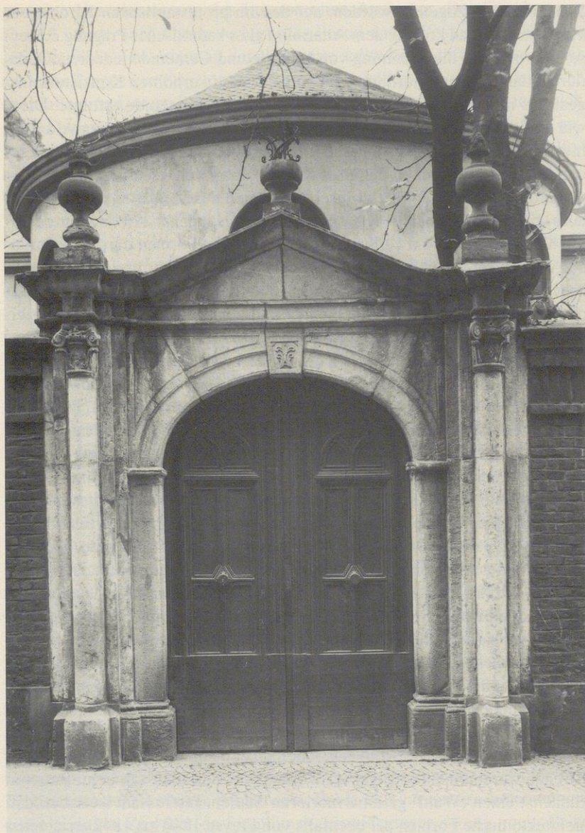
Portal zum Gelände der Mennonitenkirche (im Hintergrund) an der Menno- niten-Kirch-Straße, entstanden um 1700.
