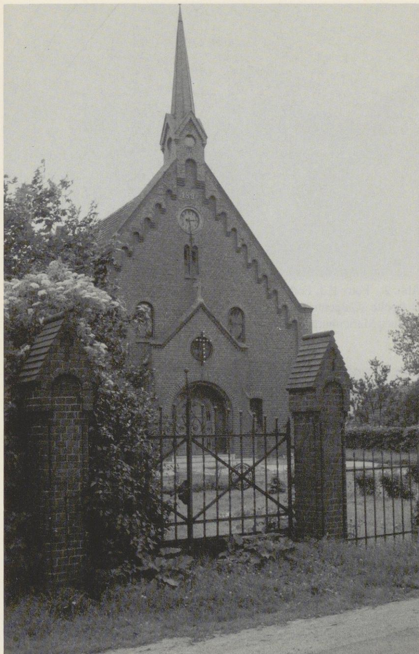
Abb. 1 Foto: P. J. Foth Ehemalige Mennonitenkirche in Montau
