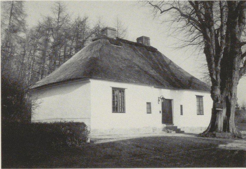
Die Mennokate bei Bad Oldesloe, 1985/86 renoviert.
